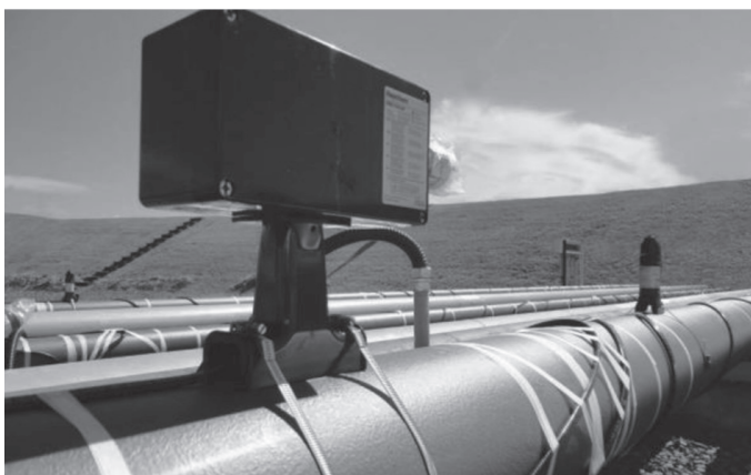
写真-1 配管への施工例
