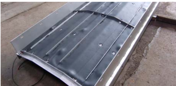
写真-7 落雪防止パネル 保温材(裏面)
