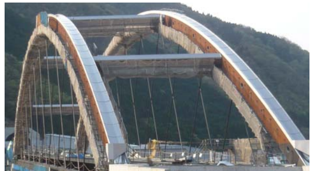
写真-10 落雪防止パネル 取付け後(全景)
