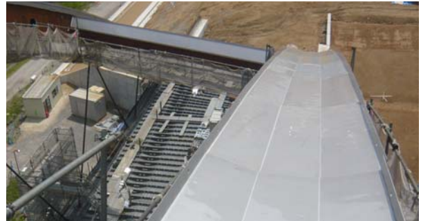
写真-9 落雪防止パネル 取付け後(アーチ上部)
