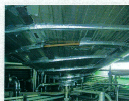
タンク下部に巻かれた 自己制御型ヒーター
