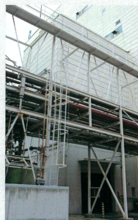
液糖貯蔵タンク室
