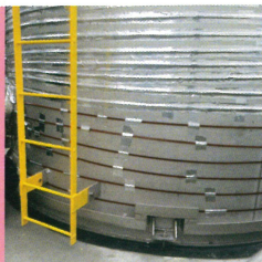
←樹脂タンク下部に自己制御ヒーターを巻き、 保温材で覆っている↑
